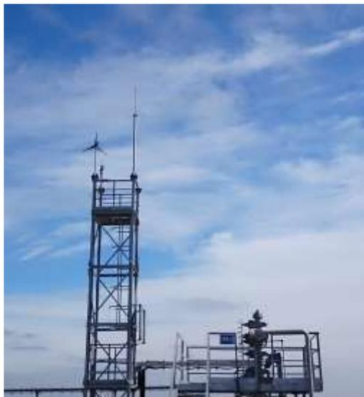
Рисунок 2. Солнечные батареи и ветрогенератор в составе комплекса СТМ КГС.
