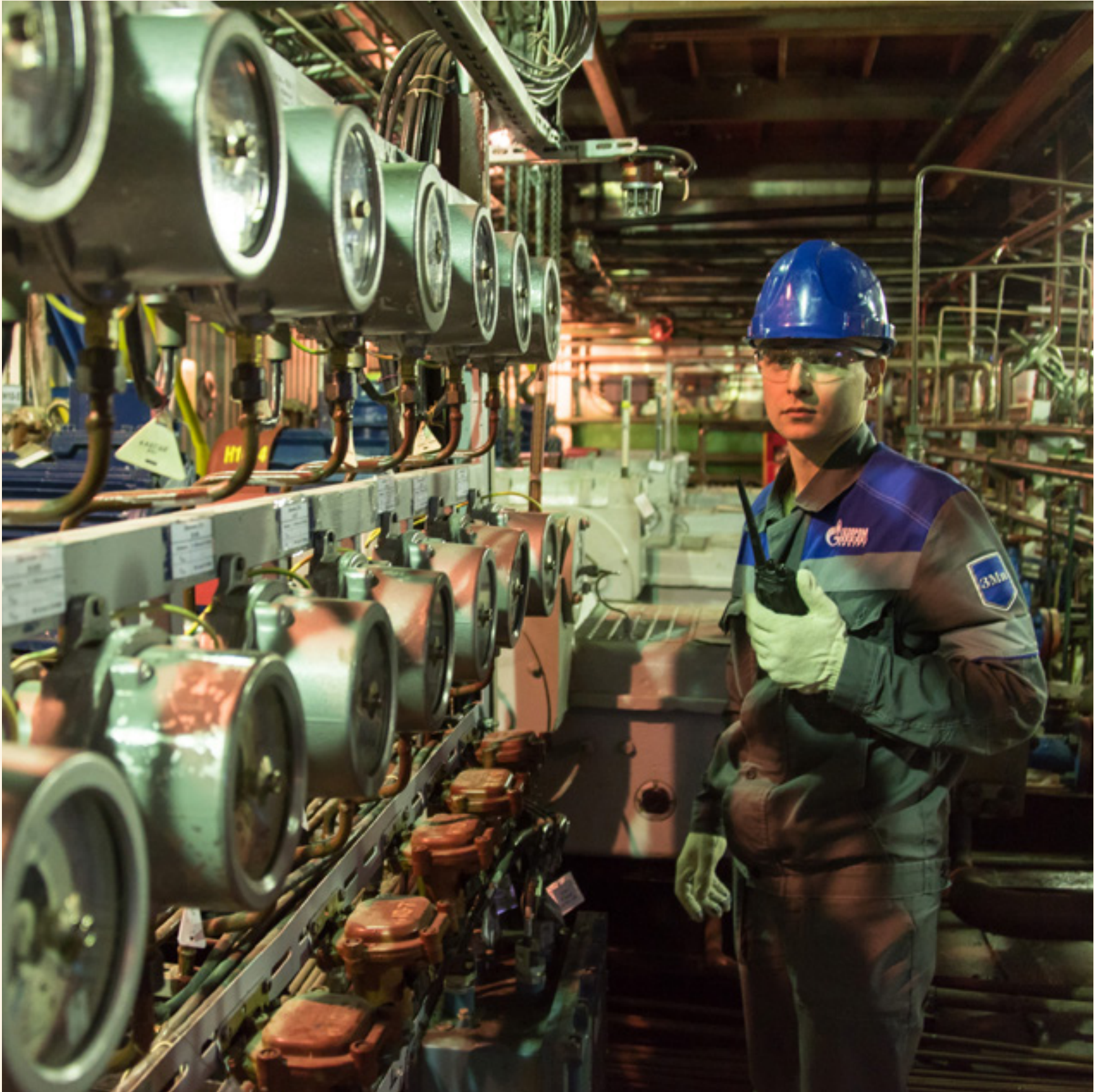
НИКОЛАЙ БУРОВ, ОПЕРАТОР ПО ДОБЫЧЕ НЕФТИ И ГАЗА УКПГ-5 ГАЗПРОМЫСЛОВОГО УПРАВЛЕНИЯ
