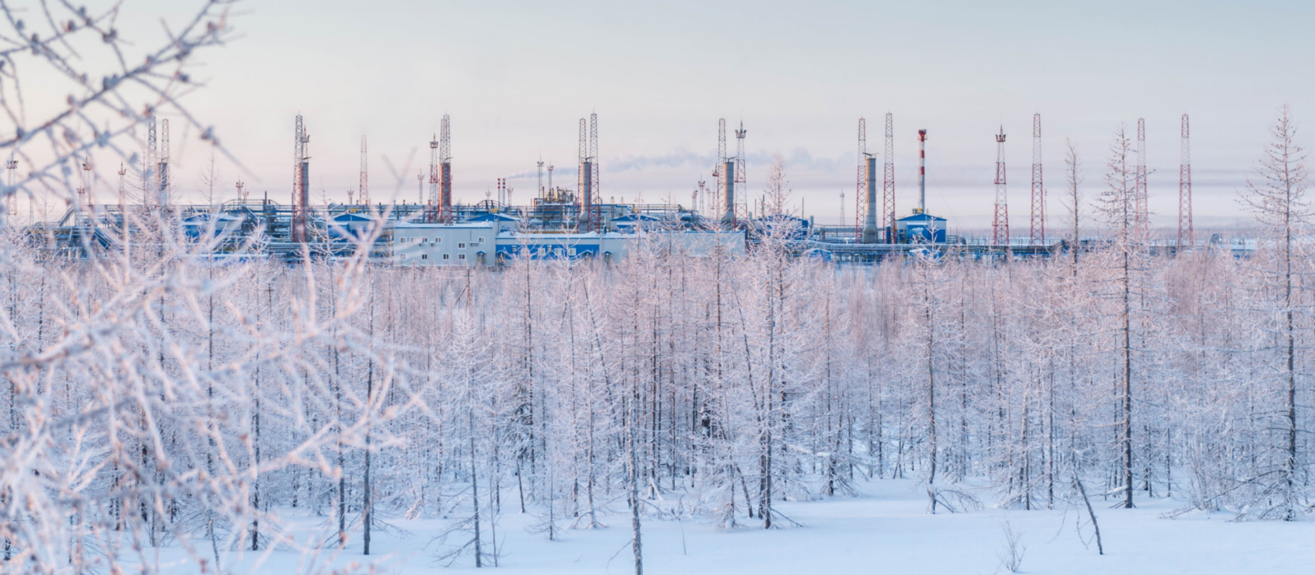
УСТАНОВКА КОМПЛЕКСНОЙ ПОДГОТОВКИ ГАЗА № 30, ЗАПОЛЯРНОГО НЕФТЕГАЗОКОНДЕНСАТНОГО МЕСТОРОЖДЕНИЯ
