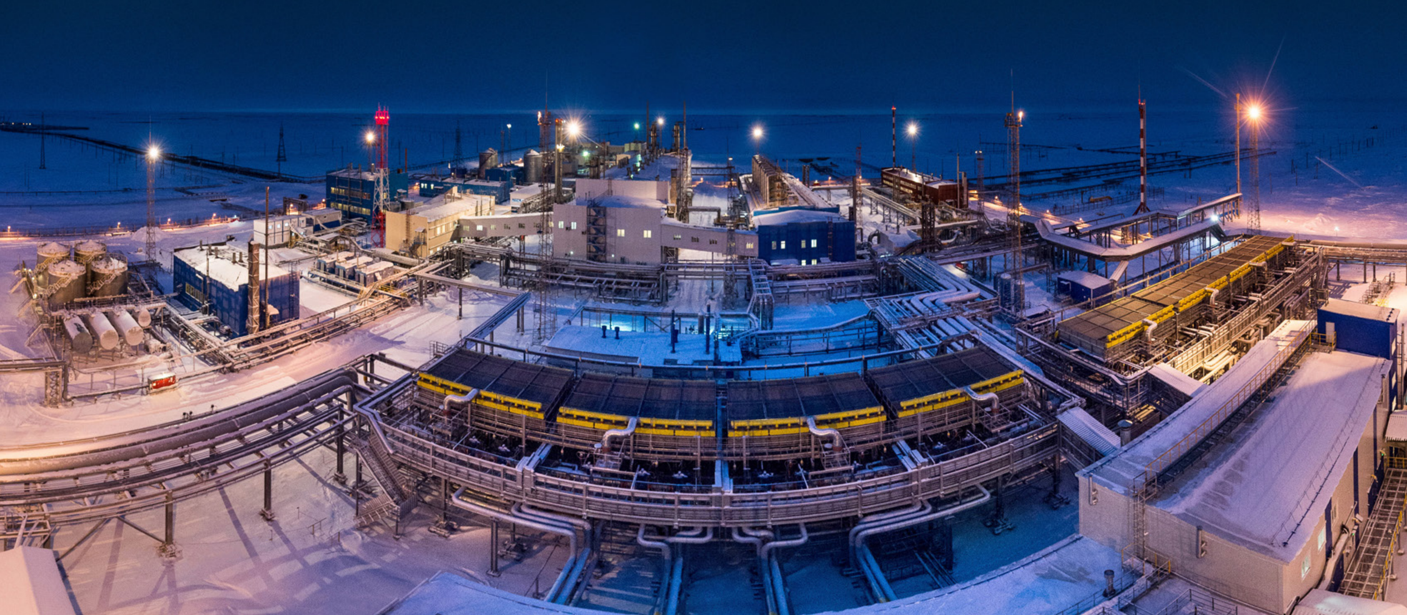
УСТАНОВКА КОМПЛЕКСНОЙ ПОДГОТОВКИ ГАЗА №9, ХАРВУТИНСКАЯ ПЛОЩАДЬ ЯМБУРГСКОГО НЕФТЕГАЗОКОНДЕНСАТНОГО МЕСТОРОЖДЕНИЯ
