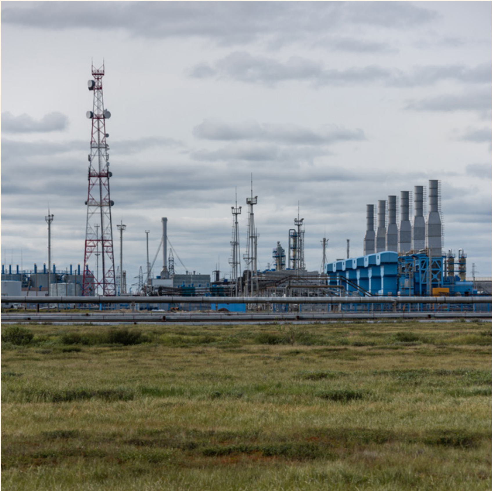
УСТАНОВКА КОМПЛЕКСНОЙ ПОДГОТОВКИ ГАЗА №1 ЯМБУРГСКОГО НЕФТЕГАЗОКОНДЕНСАТНОГО МЕСТОРОЖДЕНИЯ
