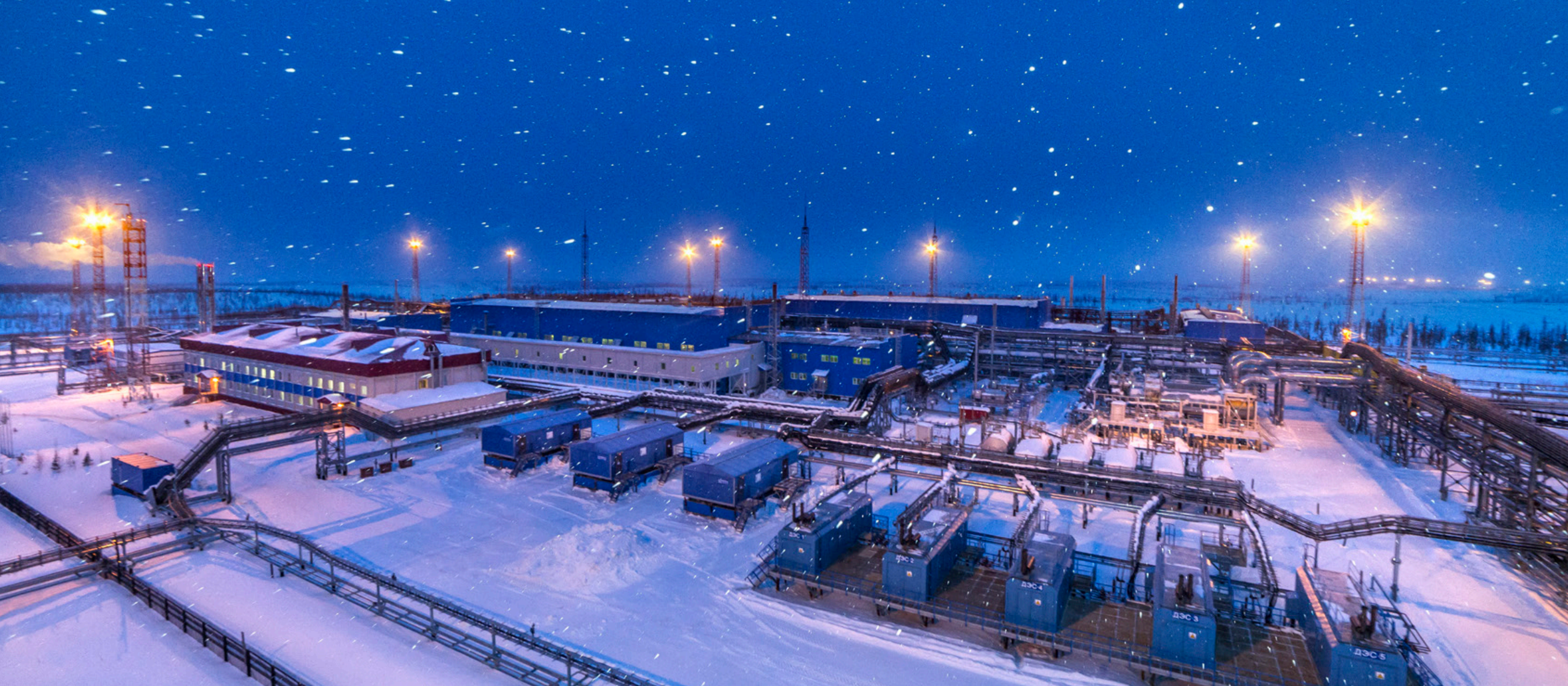
УСТАНОВКА КОМПЛЕКСНОЙ ПОДГОТОВКИ ГАЗА №2В ЗАПОЛЯРНОГО НЕФТЕГАЗОКОНДЕНСАТНОГО МЕСТОРОЖДЕНИЯ
