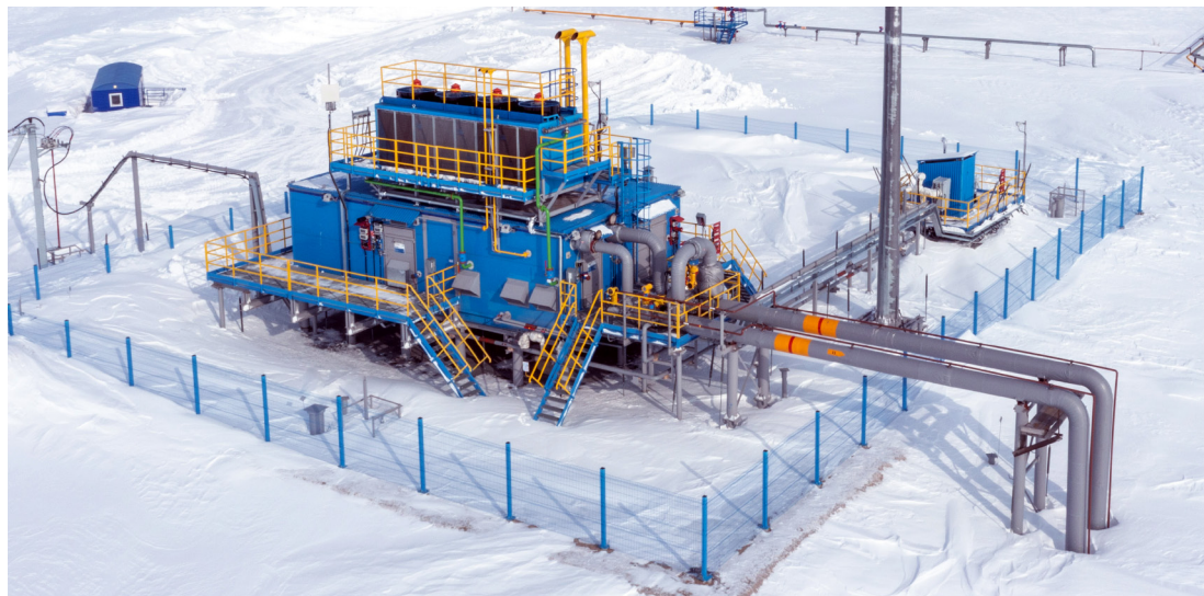
Модульная компрессорная установка на 506-й кустовой площадке ГП-5
