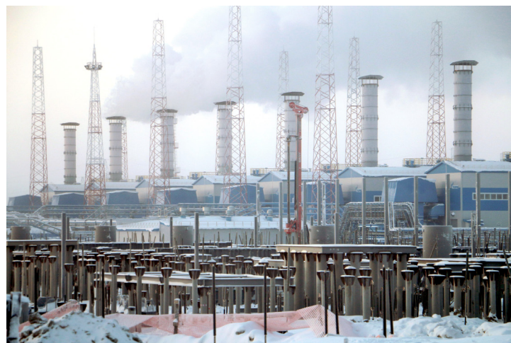
Свайное поле для второй очереди ДКС уже готово
