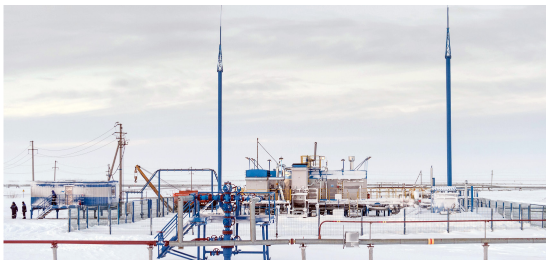
МКУ на кустовой площадке шестого газового промысла (фото Даниила ХУСАИНОВА)
