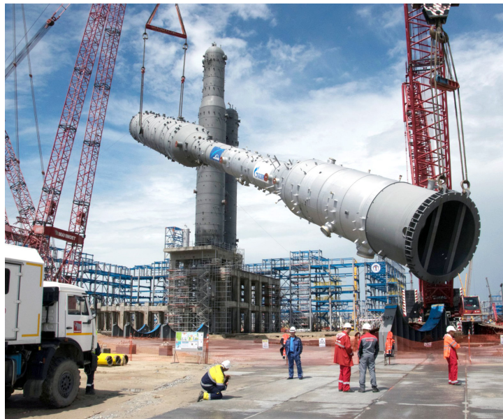
Установка колонны выделения метана (деметанизатора) на третьей технологической линии Амурского газоперерабатывающего завода
