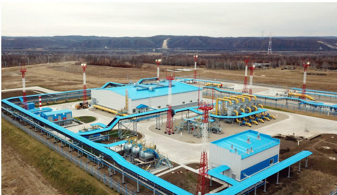
Газоицимерительная станция в районе города Благовещенска
