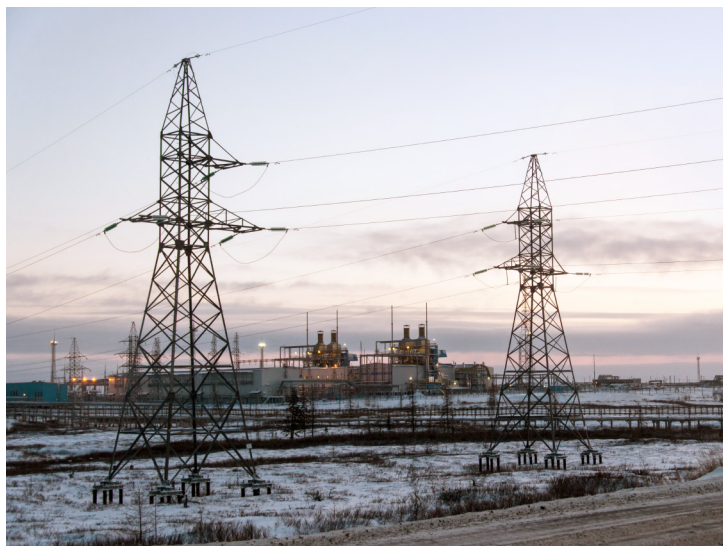
ГТЭС-48 стала третьей электростанцией на Заполярном месторождении
