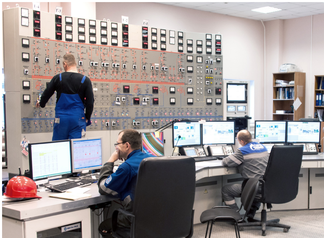
На пульте новой газотурбинной электростанции
