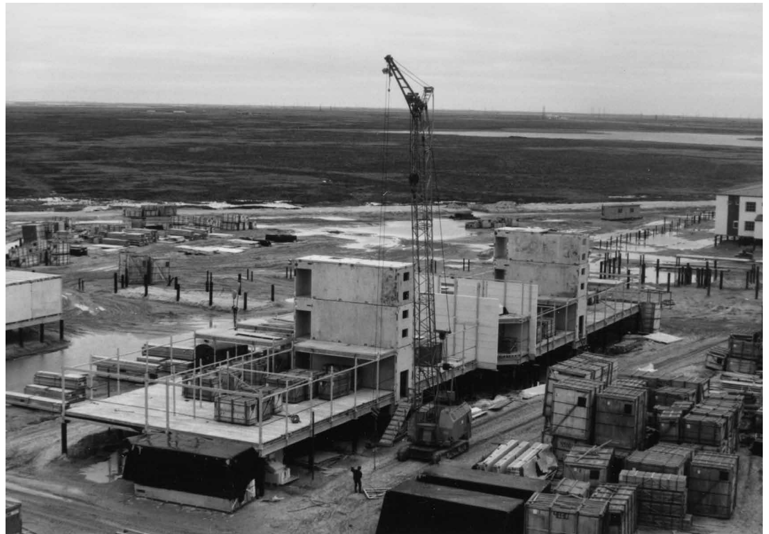
Строительство одного из финских жилых комплексов
