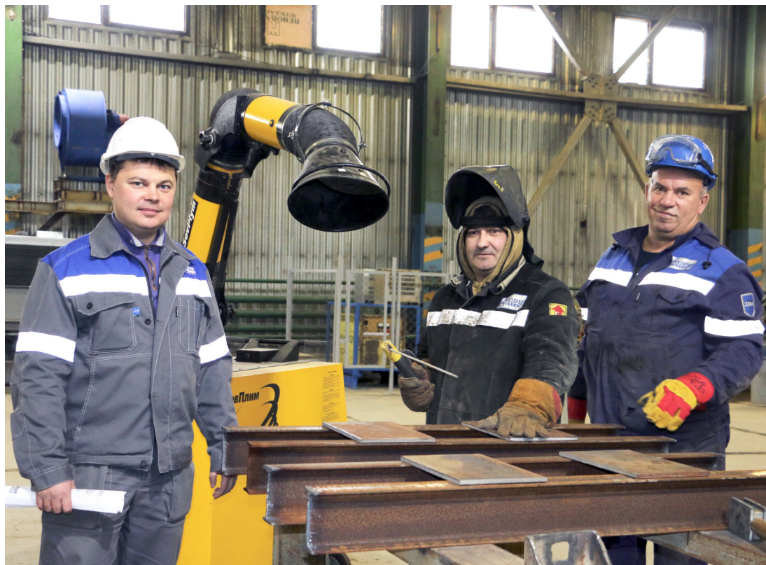
Производитель работ Алексей Горидько, электросварщик Константин Подколзин и монтажник технологических трубопроводов Игорь Фомин на новой базе УАВР на Заполярном месторождении
