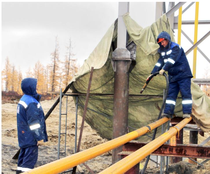
Строители готовят смонтированную эстакаду к нанесению лакокрасочного покрытия
