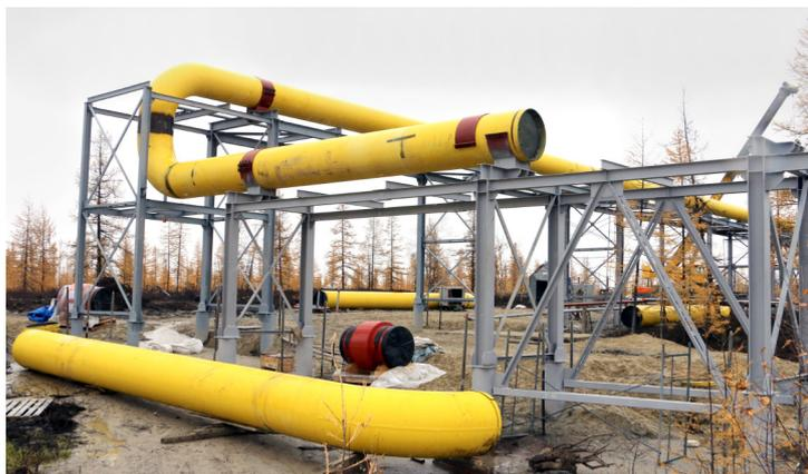
Раньше газопровод подключения проходил под землёй. Теперь его частично выносят на поверхность
