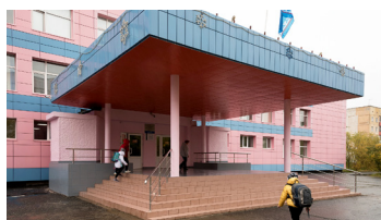
В четвёртой школе отремонтировано крыльцо
