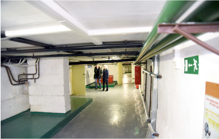
Укрытие расположено в полуподвальном помещении
