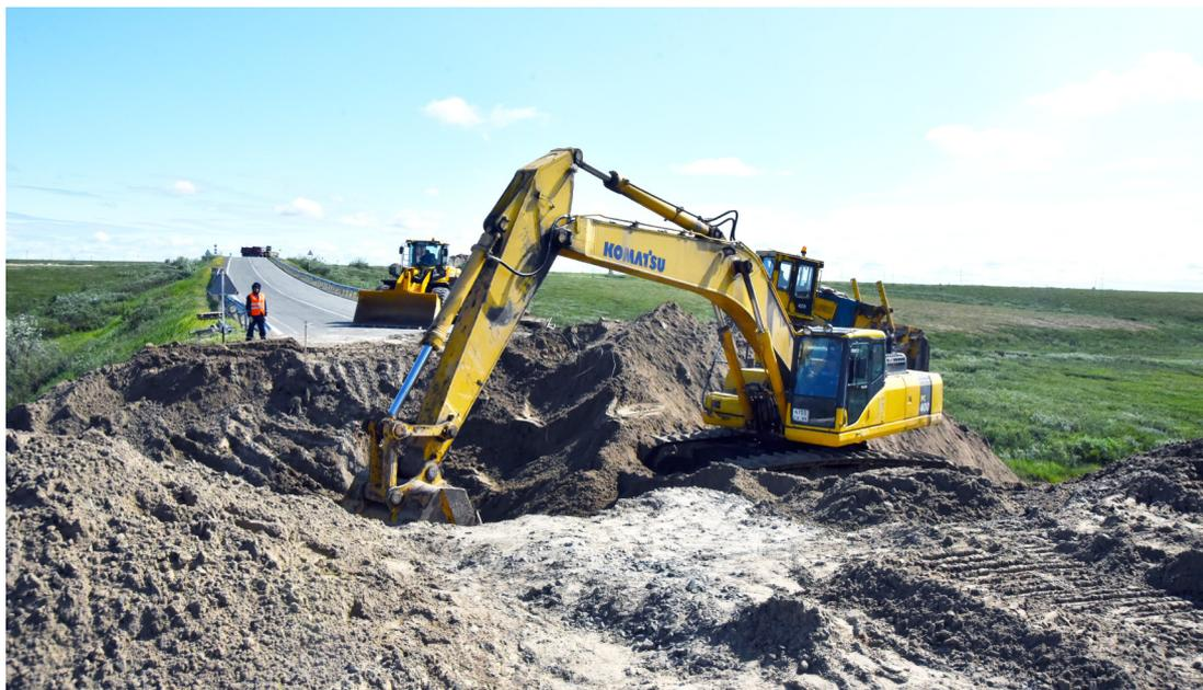
Подрядчики вскрыли участок дороги на трассе «ГП-15 – Ямбург» и готовятся заменить водопропускную трубу
