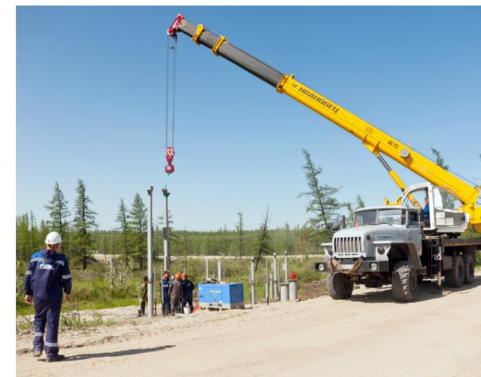
В настоящее время подрядчики заняты монтажом металлоконструкций под будущие эстакады. Они нужны, чтобы протянуть часть трубопроводов, выходящих с ГП-1С, по воздушному пути
