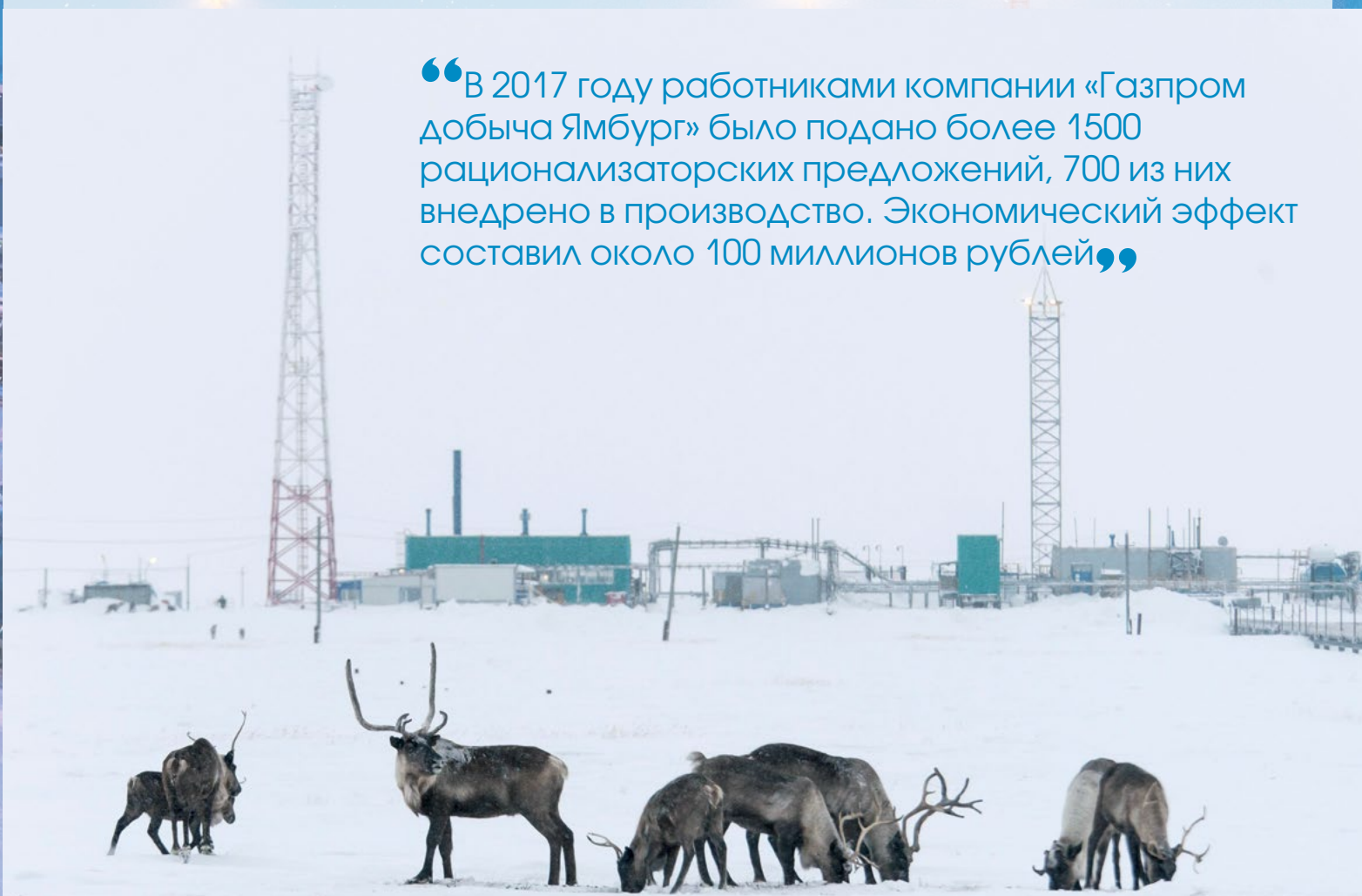
Предприятием полностью исключен сброс загрязненных сточных вод в водные природные объекты
