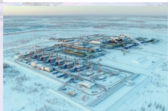
Установка комплексной подготовки газа ЗС на Заполярном нефтегазоконденсатном месторождении
