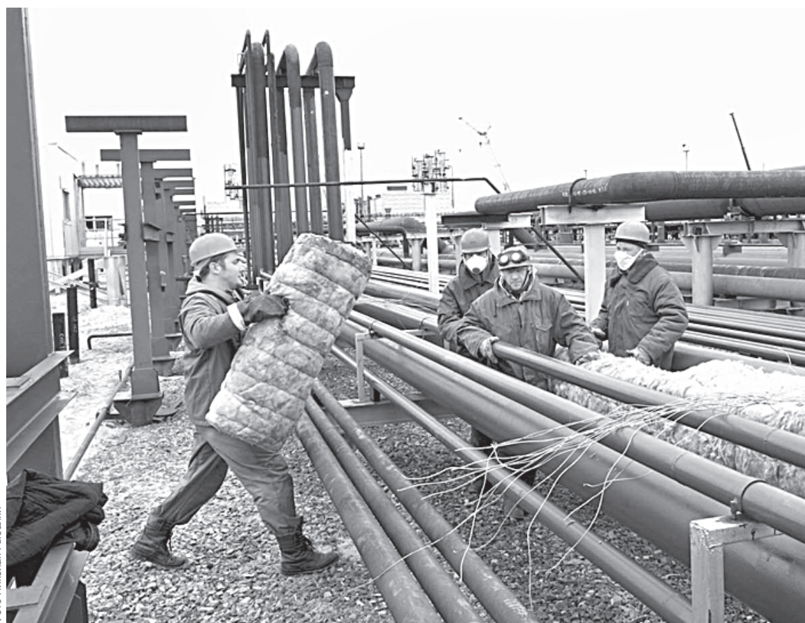
2003 год. Идет строительство первой очереди дожимной компрессорной станции на ГП-1В.
