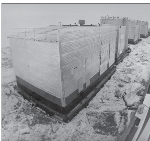
Блок-понтон для Ямбургского месторождения. Фото из архива.
