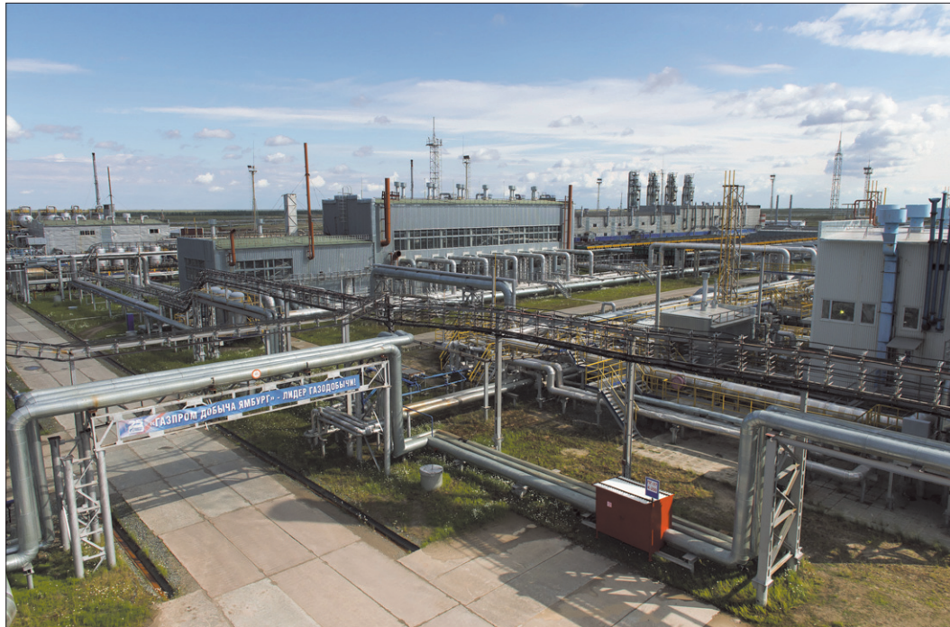
Установка комплексной подготовки газа 1В Ямбургского нефтегазоконденсатного месторождения. Фото Николая Рыбалки.
